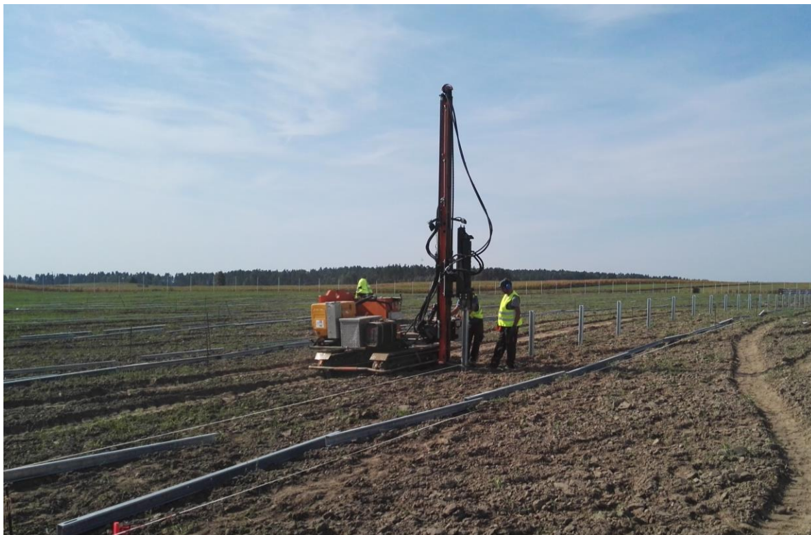
Rysunek 12 Kafar do wbijania profili nośnych
