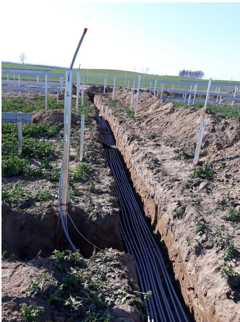
Rysunek 13 Przewody ułożone w wykopie
